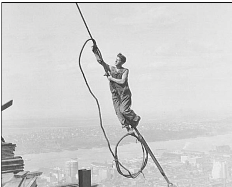
Installateur de câbles Lewis Hine – Domaine public
